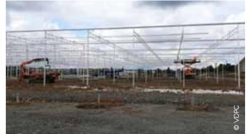
Le maire Jean-Paul Pavillon et l'adjoint à l'urbanisme Jean-Philippe Vigner sur le site du chantier d'installation
