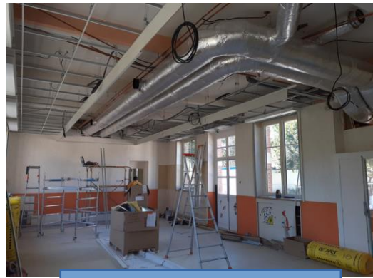
Améliorations énergétiques Travaux Ecole R.Renard
