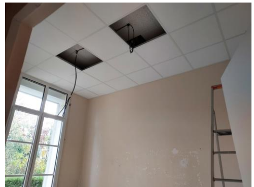
Améliorations énergétiques Travaux Mairie
