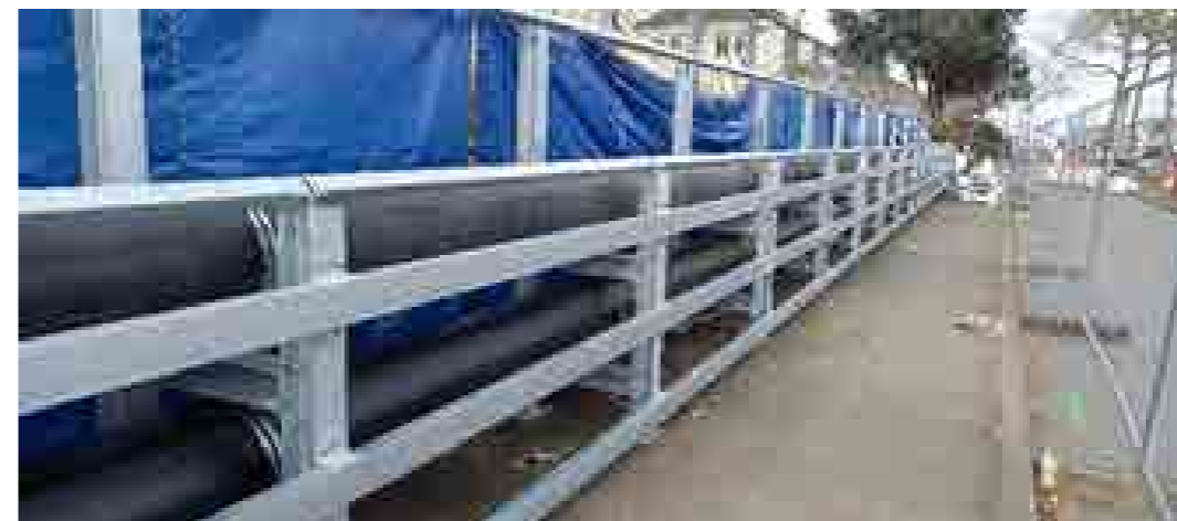
Quartier Monplaisir : Boulevard de Monplaisir – Passage du pont SNCF pour alimenter Scania et la piscine Monplaisir
