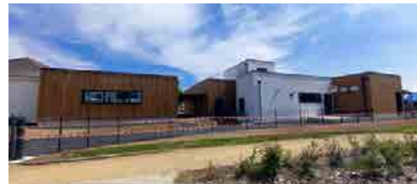
Groupe scolaire de Verrières-en-Anjou
