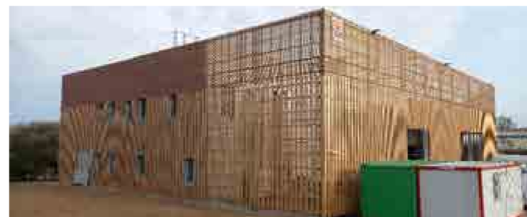
Construction de la chaufferie urbaine de Monplaisir route de Briollay
