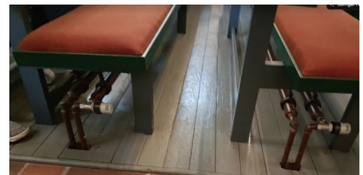
Une découverte : on voit sous les bancs, chaudement capitonnés, des rampes de chauffage pour améliorer le confort !
