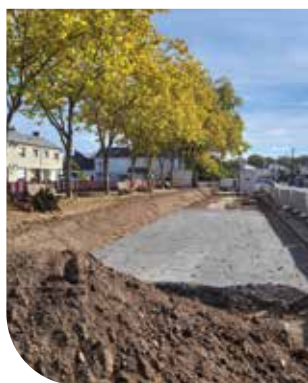
Début des travaux sur le parking du 8 mai
