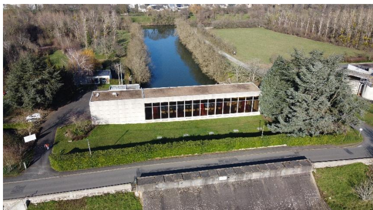
Station d'exhaure avec canal d'aménagé des eaux de l'Authion
